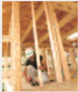
住友林業ホームエンジニアリングでは年間約3,000棟の「住友林業の家」を施工
